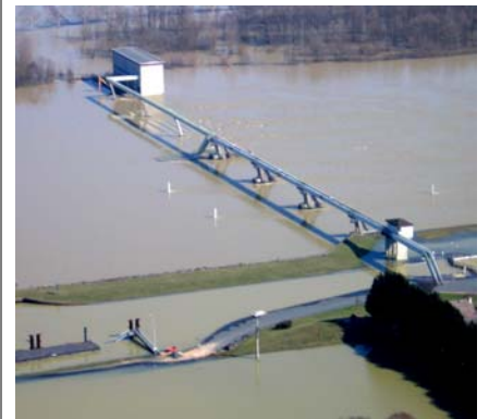
Le barrage lors de la crue de 2006 (débit 1650 m 3 /s)
